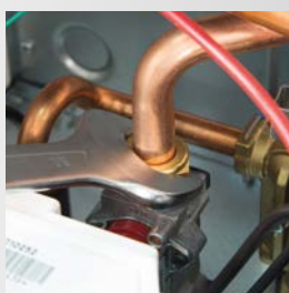
Rimozione del sistema di serraggio della tubazione
