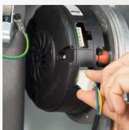
Disconnessione elettrica ventilatore
