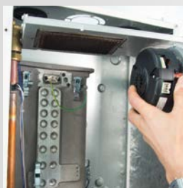
Rimozione del sistema di combustione completo
