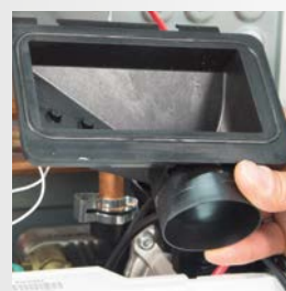
Ispezione raccolta condensa
